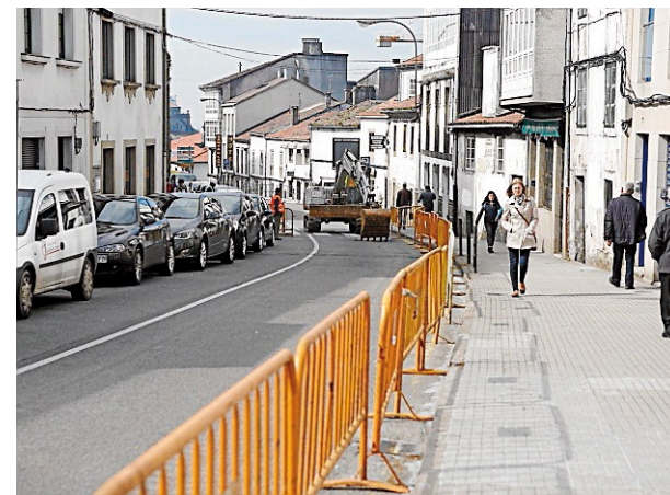
Vallas en la parte más próxima a San Roque. Foto: A. Hernández
